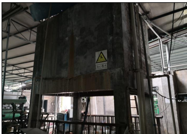
冷却循环水池现状
